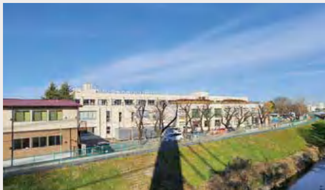
校舎長寿命化改修工事が実施される第四小学校
