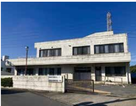
解体される旧保健センター
