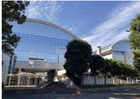
空調設備の設置工事が行われた市民総合体育館
