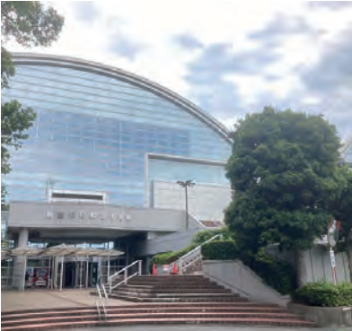
■改修を行っている市民総合体育館
