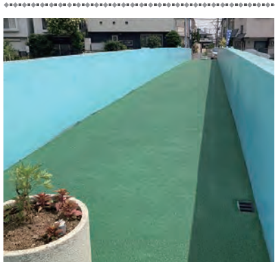
■舗装工事が完了した いしがみ橋
