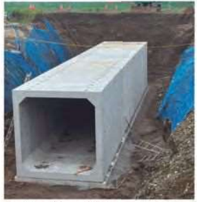
アンダーパス工事
